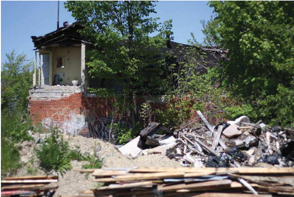
Figure 2 – Une maison abandonnée et en ruine dans un quartier de l'East Side de la ville de Detroit, désossée, envahie par la végétation et bordée d'une décharge sauvage
